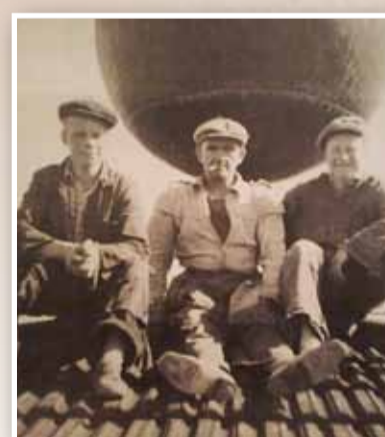
Valokuva 1930-luvun alusta esittää työmiehiä tauolla rakenteilla olevan Martinkirkon katolla.
